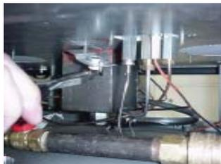
Inclinez le ventilateur sur le côté et faites le glisser dépassant des contrôles. Placez le ventilateur sur les goujons.
